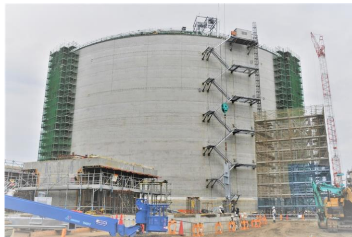
愛媛工場敷地内に、国内最大級のLNGタンクを建設中
